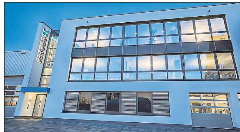
Am Grasweg in Bornholte hat Hüttenhölischer Maschinenbau ein neues Bürogebäude bezogen.
